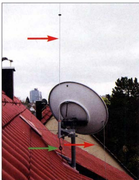
Bild 1: Wenn KW-Antennen (rote Pfeile) so unauffällig montiert sind wie hier, bieten sie kaum Anlass zum Streit mit Nachbarn oder dem Vermieter.
